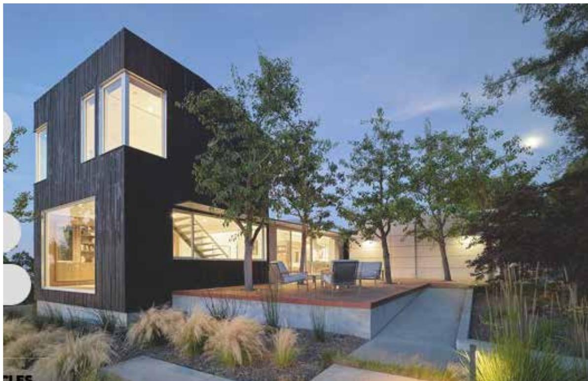
La finitura dello Yakisugi è carbonizzata, il fuoco viene impiegato in maniera sapiente e particolarmente affascinante, al fine di ottenere il risultato di una tavola in legno con caratteristiche tecniche superiori ed estetiche di grande suggestione. Il procedimento di carbonizzazione è antico, quasi un rito proveniente dal Giappone del XIV secolo.
