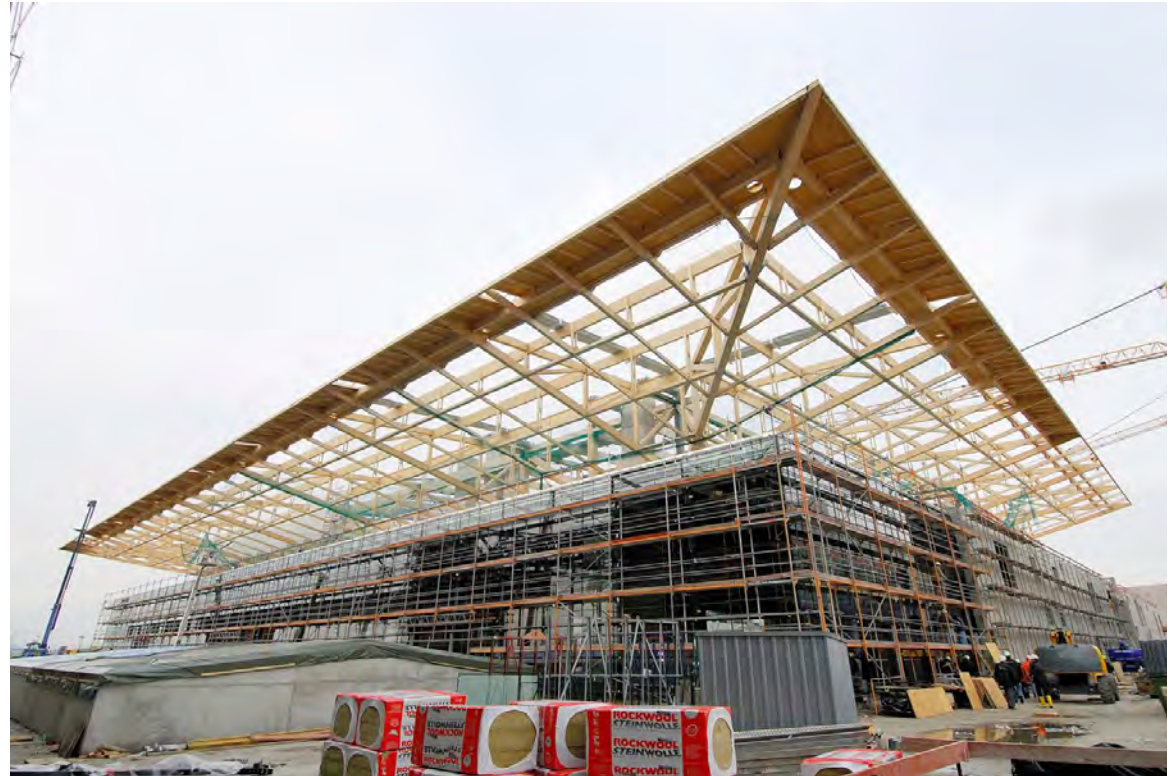
Struttura in legno
